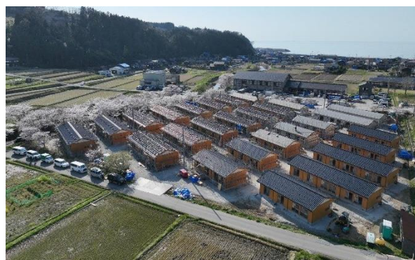
手前側が最近大工工事を始めた工区で奥側は瓦作業も進行している(町野3)
