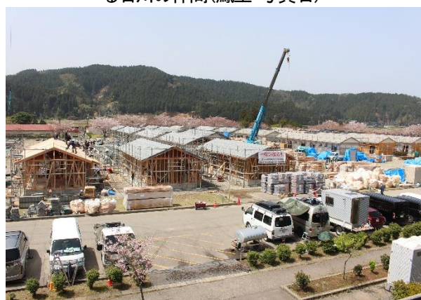
手前側が最近大工工事を始めた工区で奥側は瓦作業も進行している(町野3)
