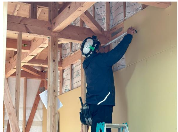
界壁工事も順調に進む
