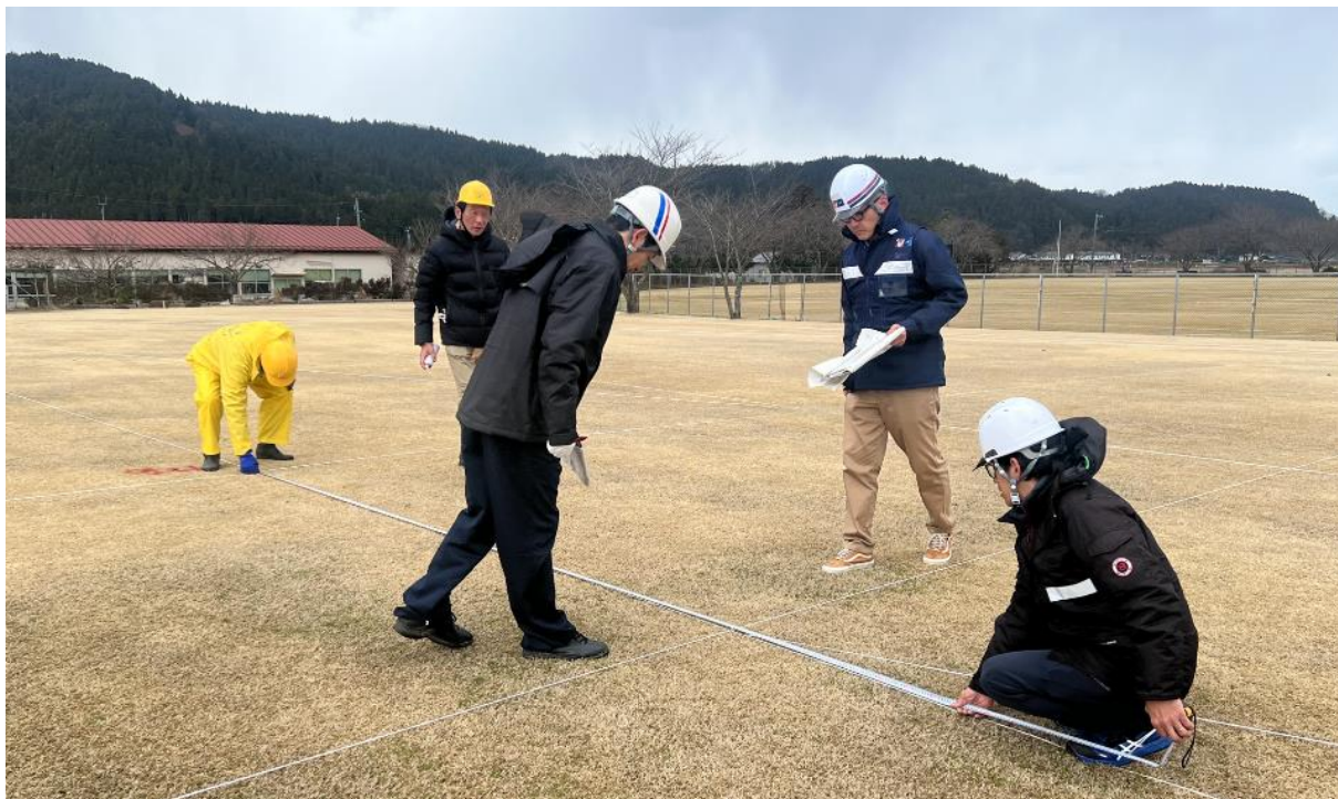
工事着手前に配置を確認する地縄張りを石川県も立ち合い実施
