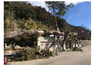
南志見周辺の土砂崩れ
