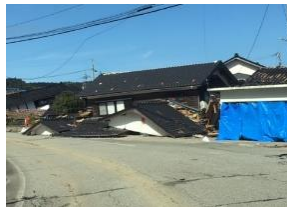
輪島市の倒壊家屋
