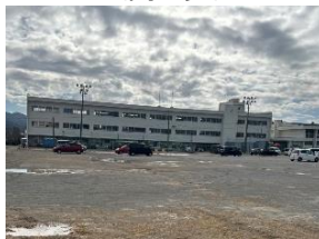
1階部分が沈下(鳳至小)
