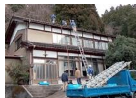
2件目まずは瓦の状態を確認
