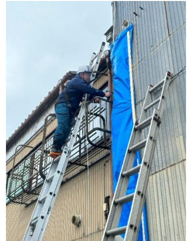
家屋と接合している建物でしたが、震災ですきまが空いてしまい雨漏りをしている状況
