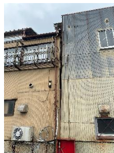
家屋と接合している建物でしたが、震災ですきまが空いてしまい雨漏りをしている状況
