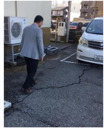
石川県連・組合本部会館（建設センター）も液状化とひび割れの被害
